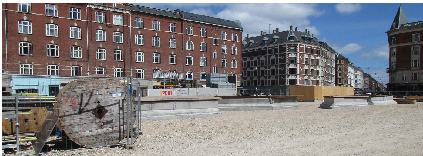
Copenaghen, lavori in corso
