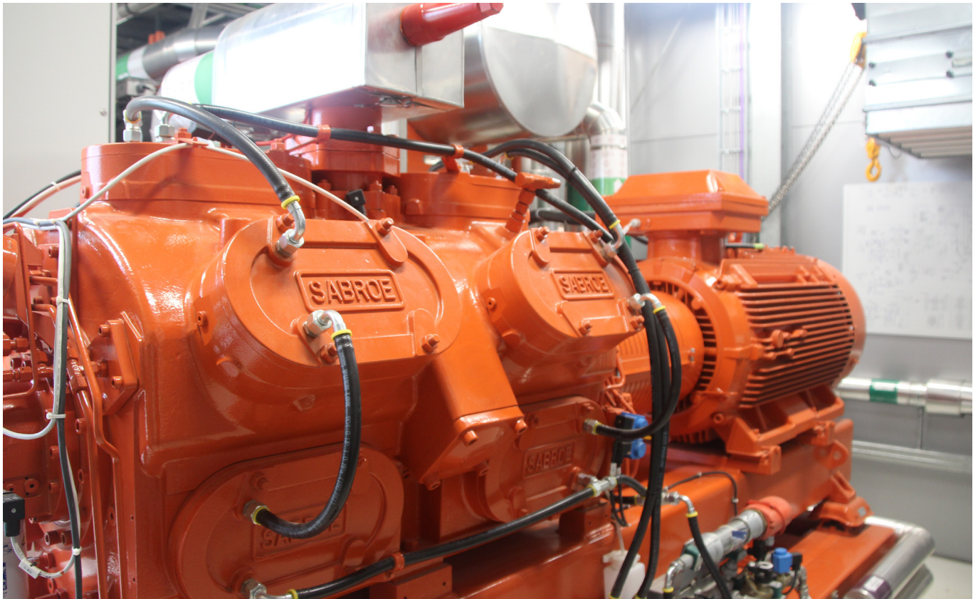
Varmepumpen styret af frekvensomformere sender ca. 70 °C - 80 °C grader varmt vand ud i systemet, og får ca. 40 °C grader varmt vand retur til centralen. Anlægget er leveret og monteret af Johnson Controls Aps med rådgivning fra COWI A/S.
