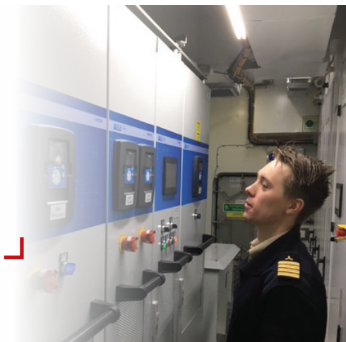
VACON® frequentieregelaars drijven de hoofdvoortstuwing en de schroeven aan
