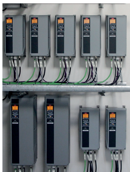
VLT® AutomationDrive FC 302 frekvensomriktare styr de stora fjärrvärmepumpsystemen.
