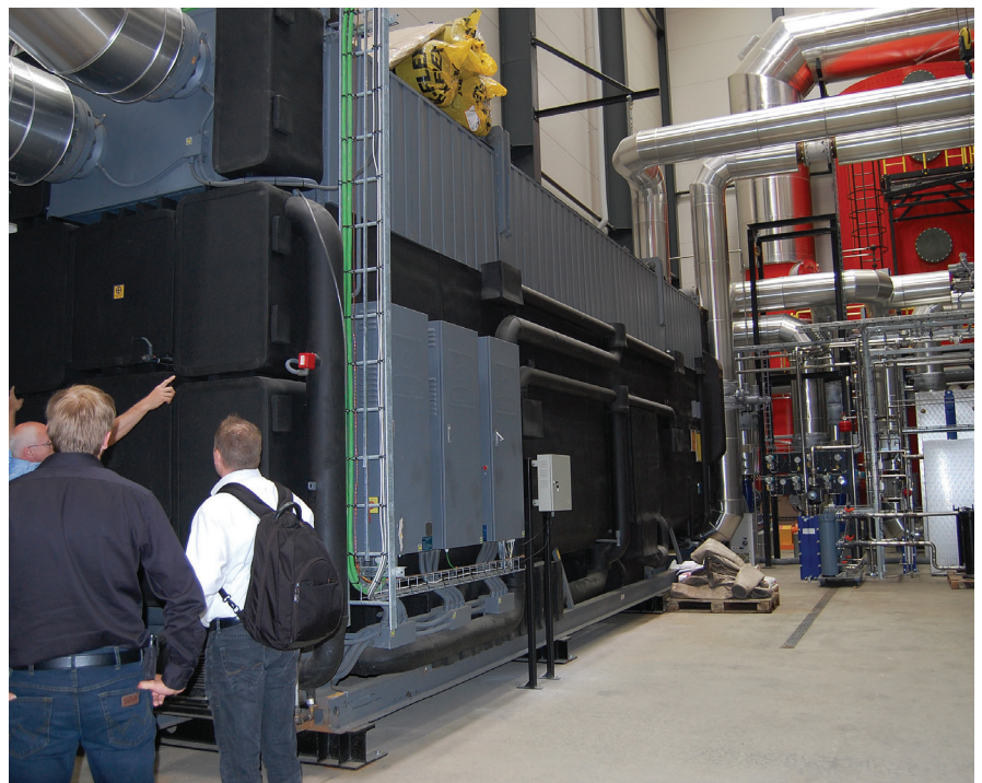
I forgrunden en absorber. I baggrunden skrubber.
