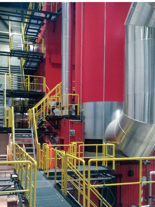
Vertikal biobrændselskedel og rensning af røggas
