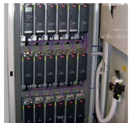
Frequenzumrichter lassen sich zentral, in Schaltschränke oder dezentral in der Nähe des Antriebs installieren. Beide Konzepte haben Vor- und Nachteile.
