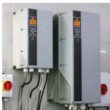
Frequenzumrichter lassen sich zentral, in Schaltschränke oder dezentral in der Nähe des Antriebs installieren. Beide Konzepte haben Vor- und Nachteile.
