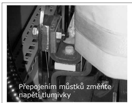
Obr. 5-6. Způsob připojení tlumivek u velikostí FR13/14
