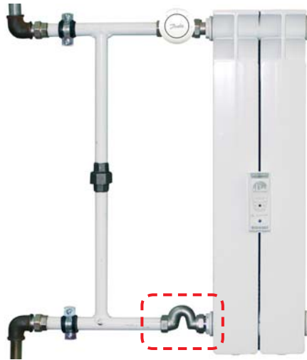
Рис. 10. Дросель зворотного потоку RTD-CB
