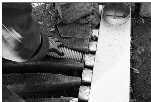
Manifold placeret i isoleringsmateriale i gulv for støbning.
