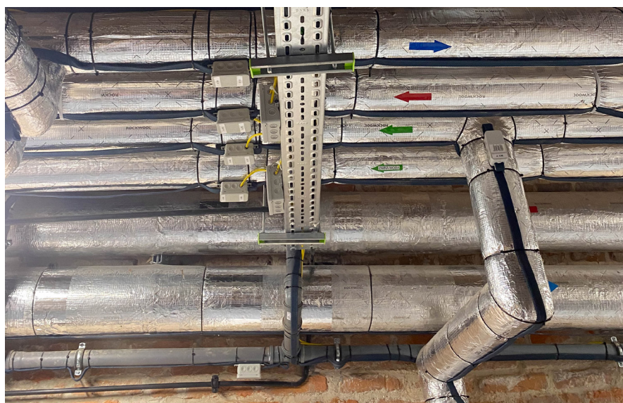
System detekcji liniowej chroni wodę użytkową oraz wodę lodową
