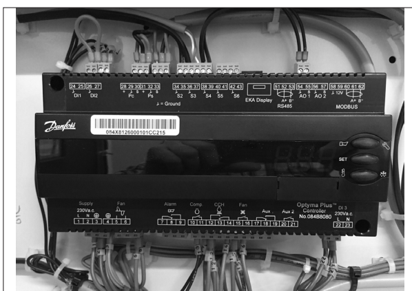
Illustration 4 : Câblage normal
