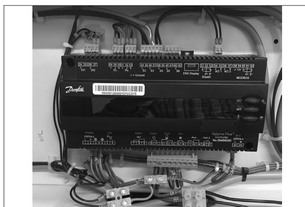
Abbildung 5: Vorübergehende Verdrahtung
