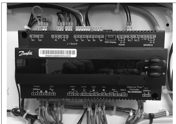
Abbildung 4: Normale Verdrahtung
