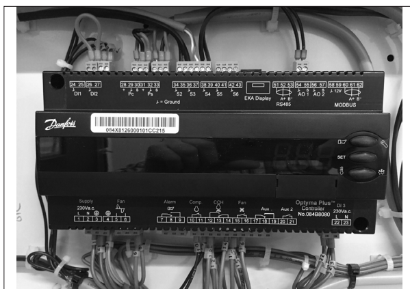
Bild 4: Normale Verdrahtung
