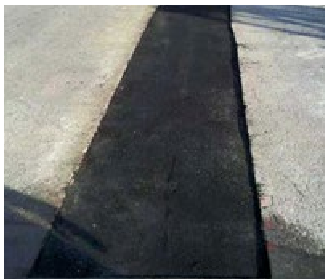
Fig. 2 – Kablerne er beskyttet af betonen forud for næste asfaltudlægning.
