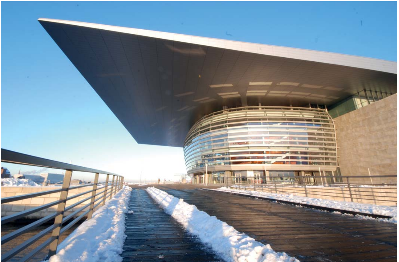
Практичне відображення роботи системи сніготанення
