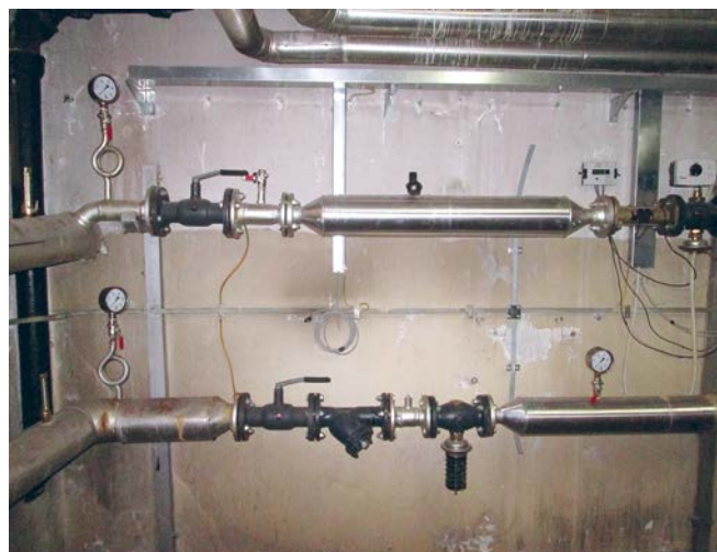
Тепловий пункт «Ципелісі» після реконструкції
