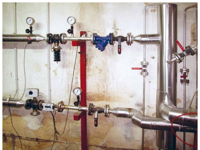
Теплова станція 'ВКС' після реконструкції.
