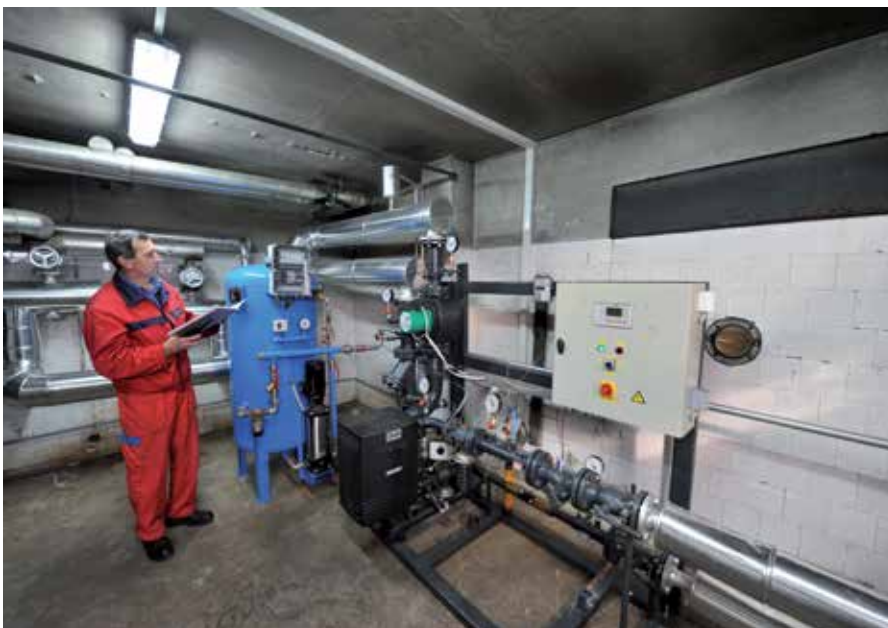
Тепловий пункт 15-поверхової будівлі в центрі Тузли: працівник теплопостачальної компанії перевіряє та занотує дані споживання та коливань температури. Це значне покращення якості життя для мешканців.
