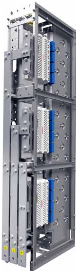
Bild 5.5.4 4Q-Inverter mit Flüssigkeitskühlung
