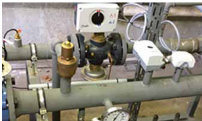
Sous-station du RCU de Valence équipée de vannes de régulation indépendantes de la pression différentielle AV-QM + Actionneur AME Danfoss.
