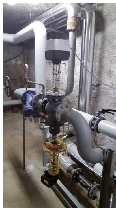
Sous-station n°70 du RCU de Valence équipée de vannes de régulation indépendantes de la pression différentielle AFQM 2 + actionneur AME 658 et actionneur intelligent iSet Danfoss.
