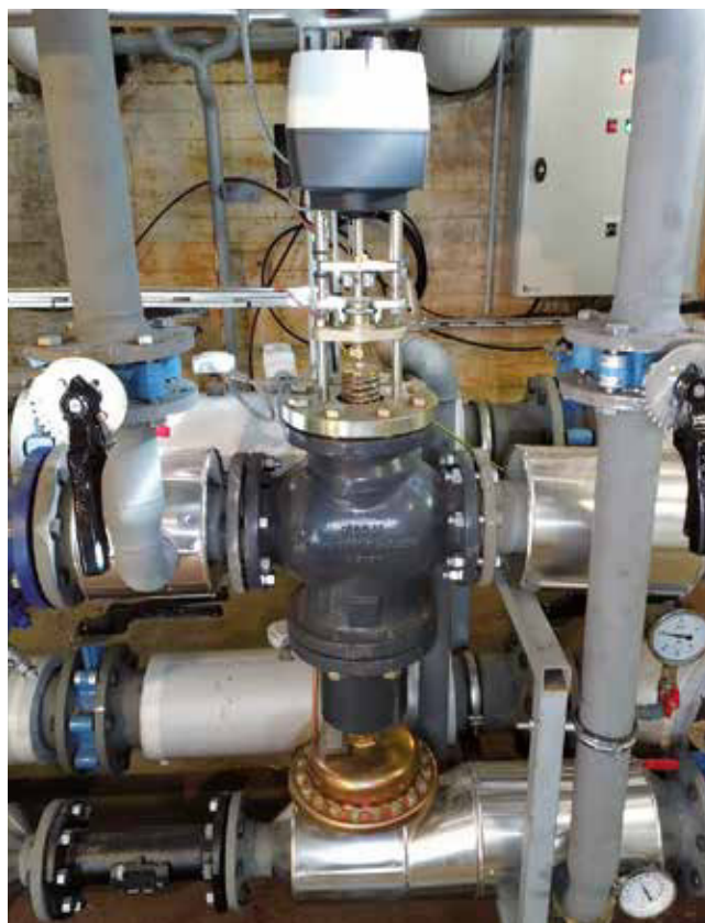
Sous-station du RCU de Valence équipée de vannes de régulation indépendantes de la pression différentielle AF-QM + Actionneur AME Danfoss.
