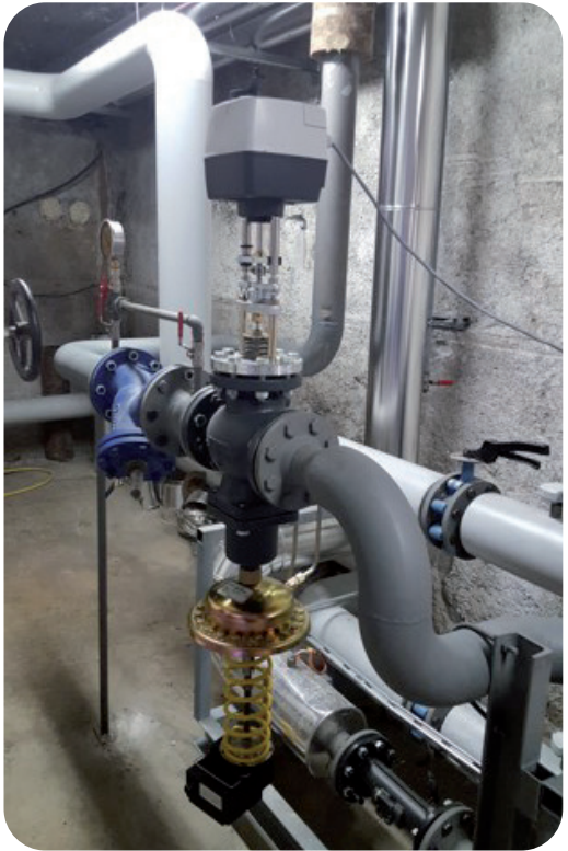
Sous-station n°70 du RCU de Valence équipée de vannes de régulation indépendantes de la pression différentielle AFQM 2 + actionneur AME 658 et actionneur intelligent iSet Danfoss.
