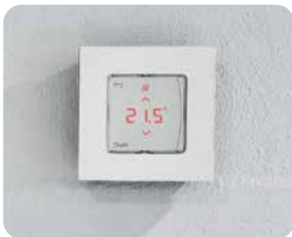
↑ Der intelligente Danfoss Icon™-Raumthermostat, fortschrittliche Steuerung der Fußbodenheizung in Wohnräumen
