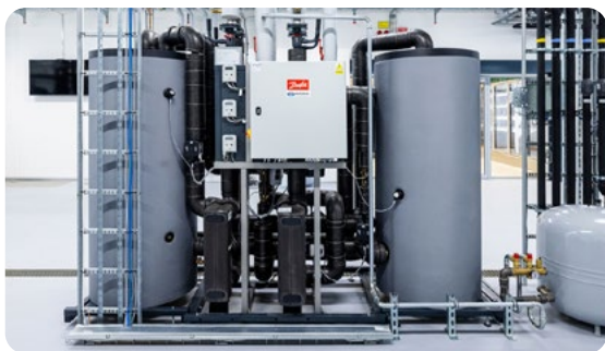
Блок рекуперації тепла (HRU)
