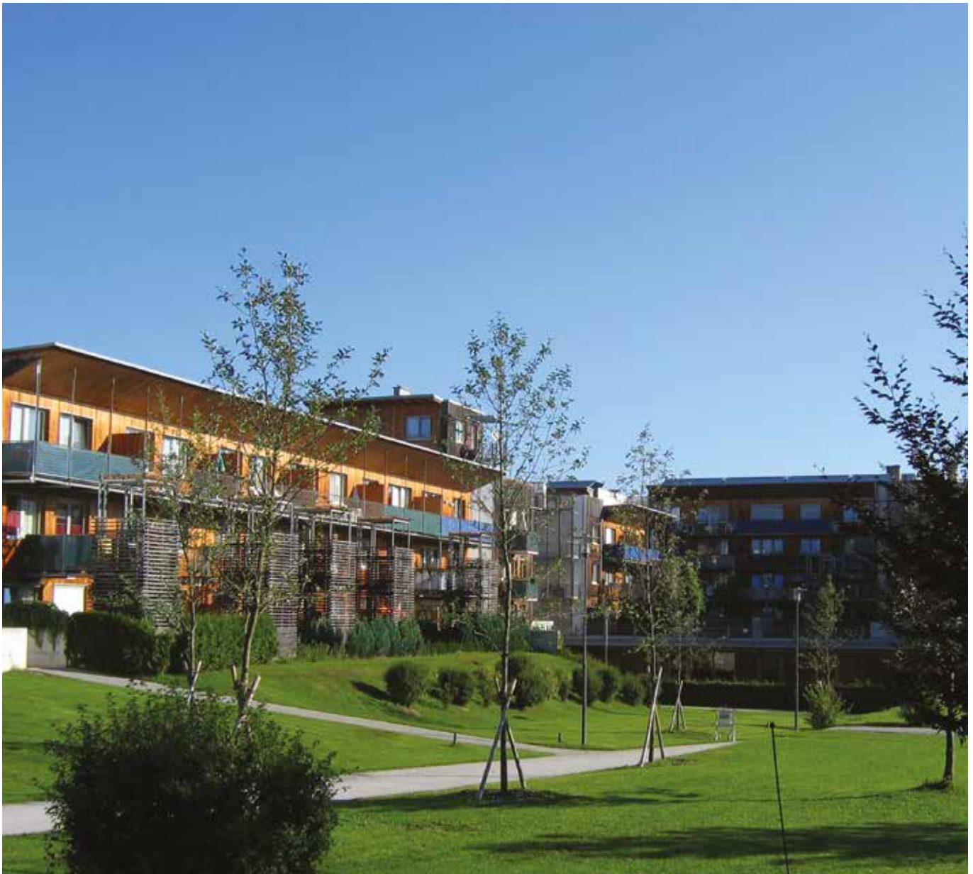
Salzburg, Austria — budynki wielorodzinne z wewnętrzną siecią ciepłą.
