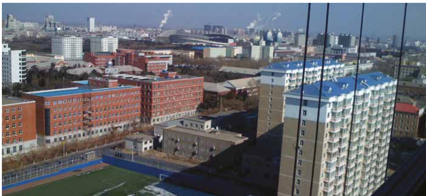
Changchun, Chiny — domy wielorodzinne i budynki komercyjne z wewnętrzną siecią ciepłą.
