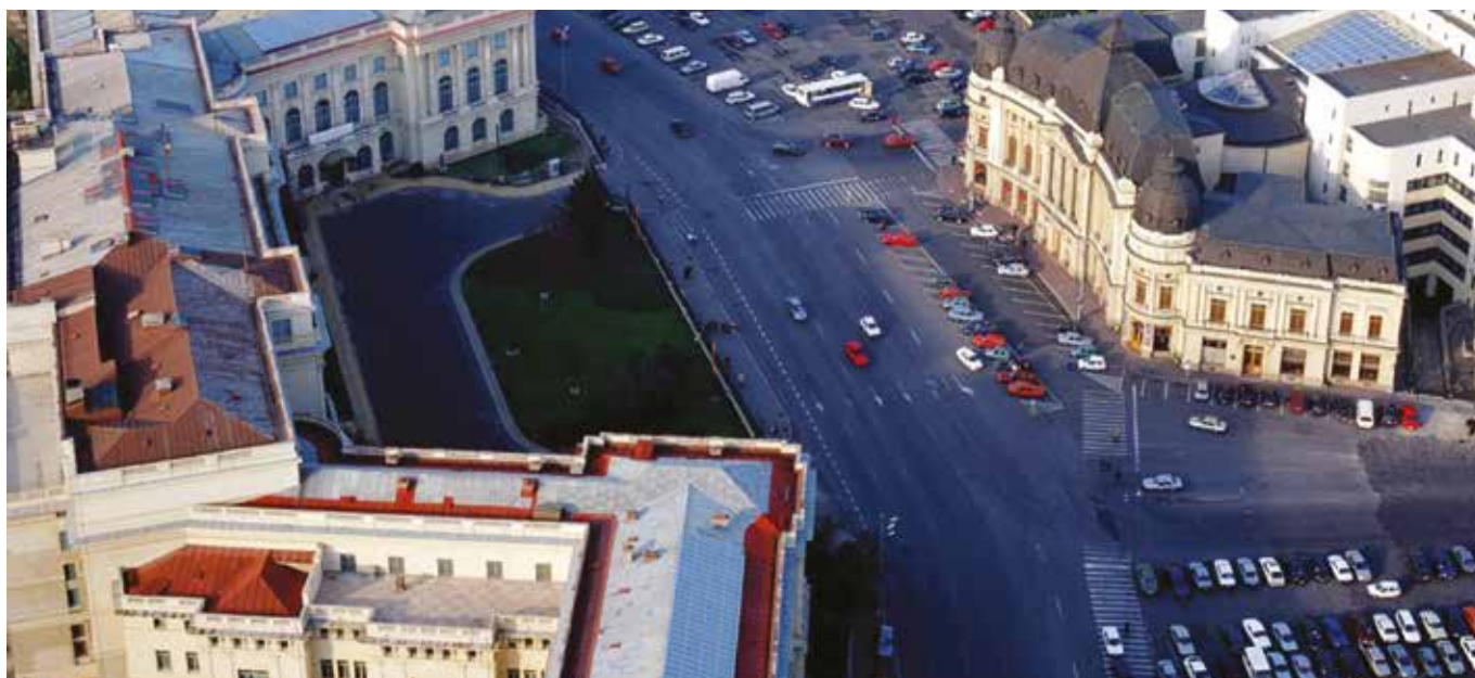
Bukareszt, Rumunia — domy wielorodzinne i budynki komercyjne zasilane z sieci ciepłej.
