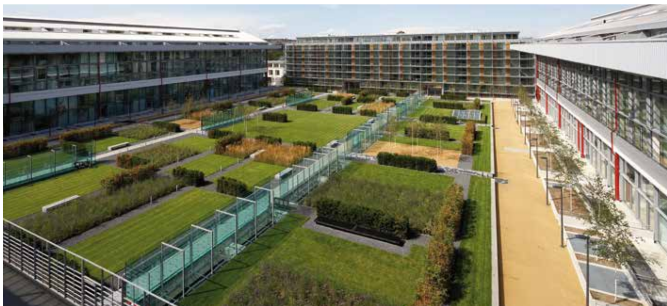
Londyn, Wielka Brytania — domy wielorodzinne z ogrzewaniem i przepływowym przygotowaniem CWU.
