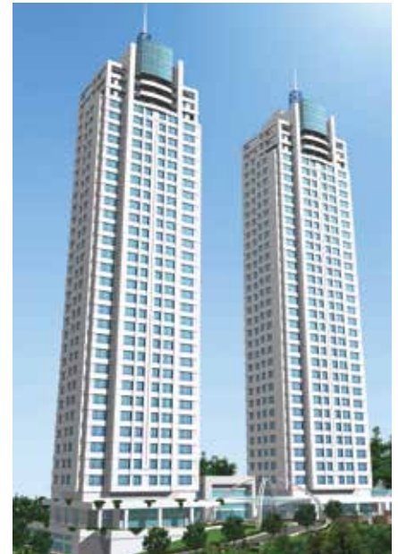
Istanbul, Turcja — domy wielorodzinne i budynki komercyjne z przepływowym podgrzewaniem CWU.
