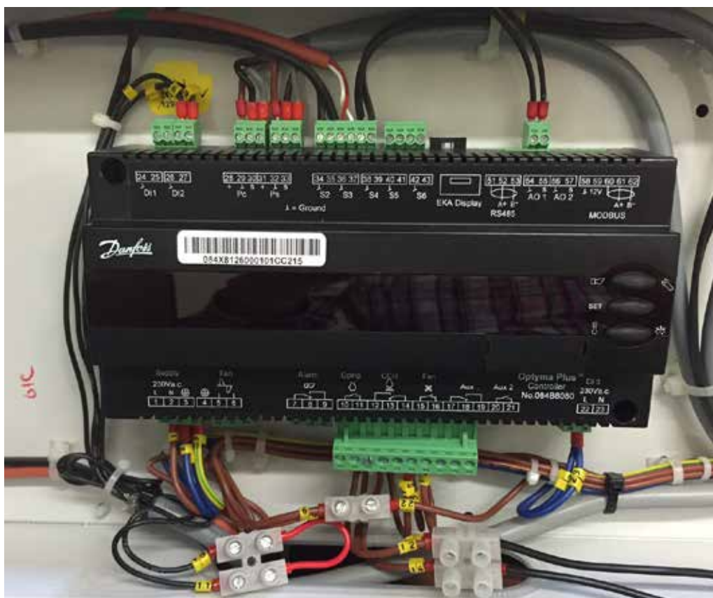
Ilustración 2: cableado de emergencia
