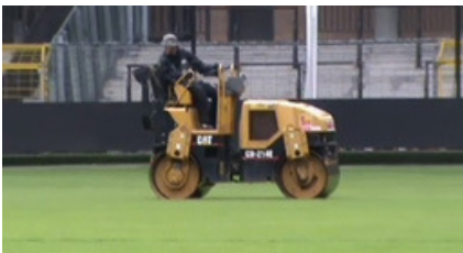
După instalarea cablului, este necesar să se cultive iarba și să fie tasat solul cu ajutorul unui tăvălug
