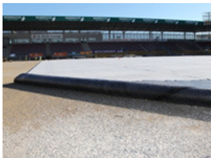
Covoraș de scurgere, amplasat direct pe sol.
