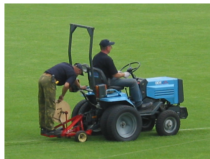
După instalarea cablului, este necesar să se cultive iarba și să fie tasat solul cu ajutorul unui tăvălug
