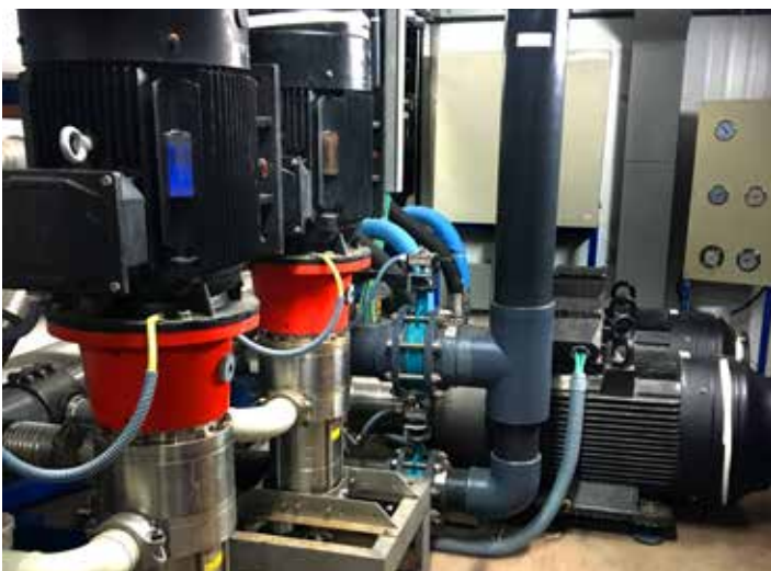
La solución en contenedores con bombas APP 38 y dispositivos de recuperación de energía iSave 50
